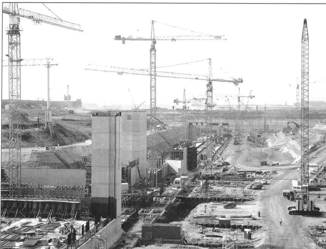
Le chantier titanesque de l'écluse du "Deurganckdock" (septembre 2013).
